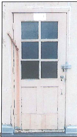
Metal clad wood door
